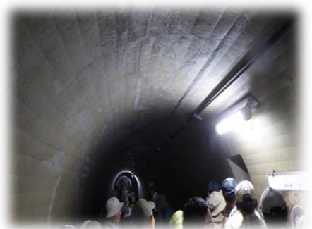
トンネル内部
