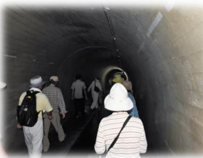
トンネル内部
