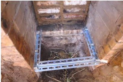
壁の前ロストル置台設置
