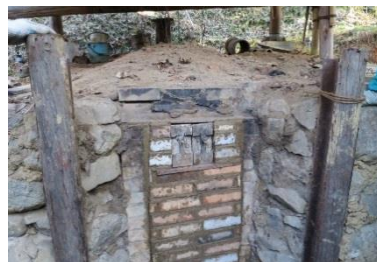
前の壁レンガ積み完了最上段窓は燃料の追加や燃焼具合を見るためのものです。
