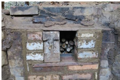
前の壁レンガ積み完了最上段窓は燃料の追加や燃焼具合を見るためのものです。
