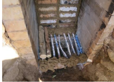
ロストルの上にバイタを積んでいきながらレンガを積み上げます。
