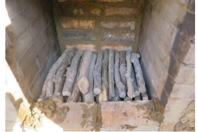
ロストルの上にバイタを積んでいきながらレンガを積み上げます。
