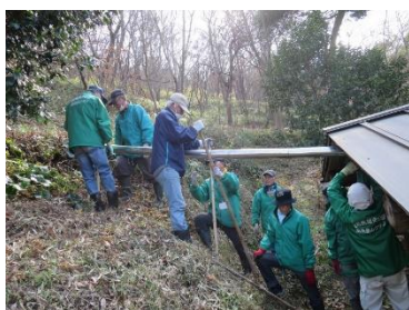
炭焼き窯の煙突の取り付け
