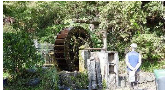
水車発電装置(鳴川の自然流水を利用)
